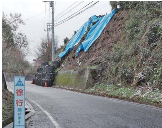
安全対策が急がれる法面崩落災害現場
