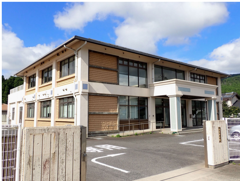
写真：池田浄水場
