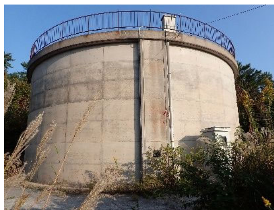
写真：要木配水池
