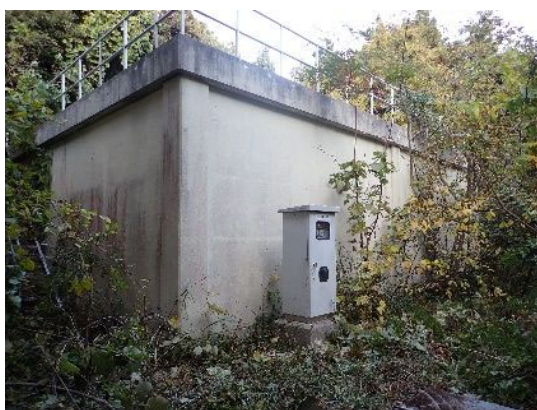
写真：原田配水池
