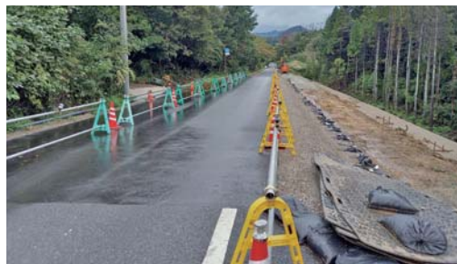
迅速に復旧作業中(写真提供:県土整備局)
