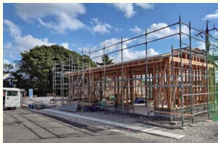
工事が進む交通安全教育センター
