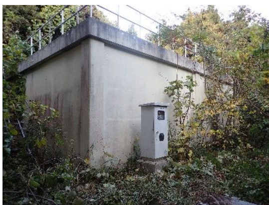
写真：原田配水池
