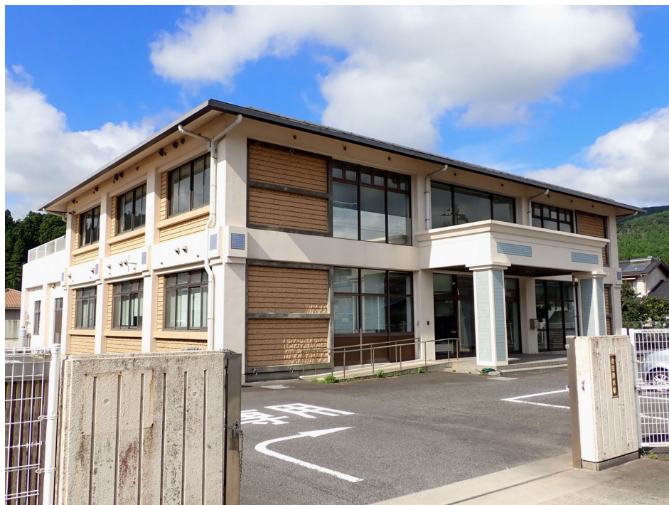
写真：池田浄水場
