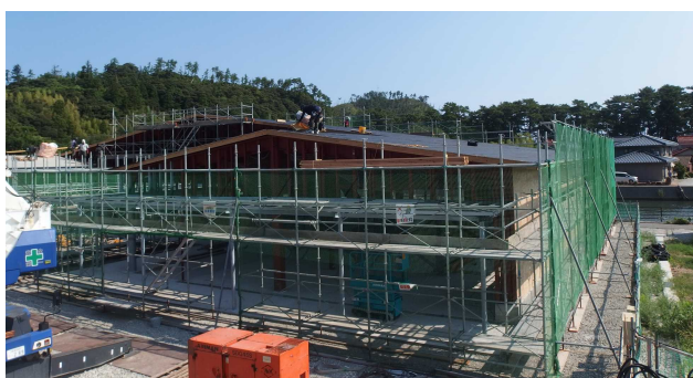
上：鉄骨組立て状況（現場事務所2階から見る） 下：屋根下地、外壁下地の一部貼り付け（8月22日）
