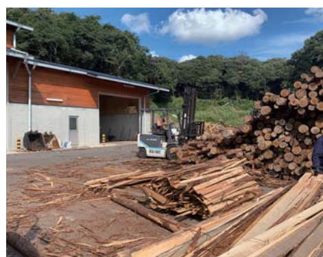
▲木質ペレット製造工場
