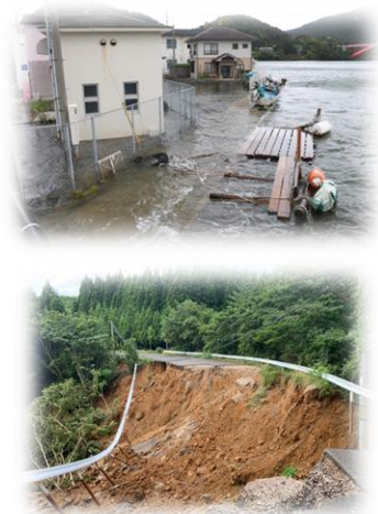
▲ 本町における豪雨・高潮による被害
