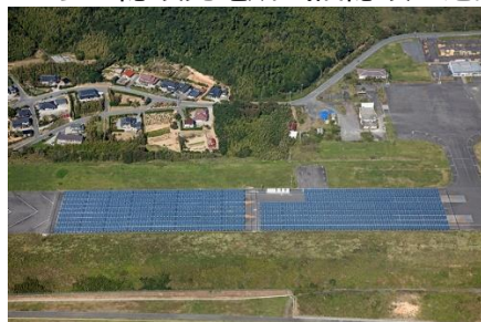
旭メガソーラー隠岐発電所 (旧隠岐空港跡地)
