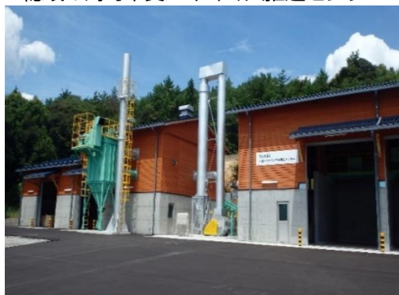
隠岐の島町木質バイオマス推進センター
