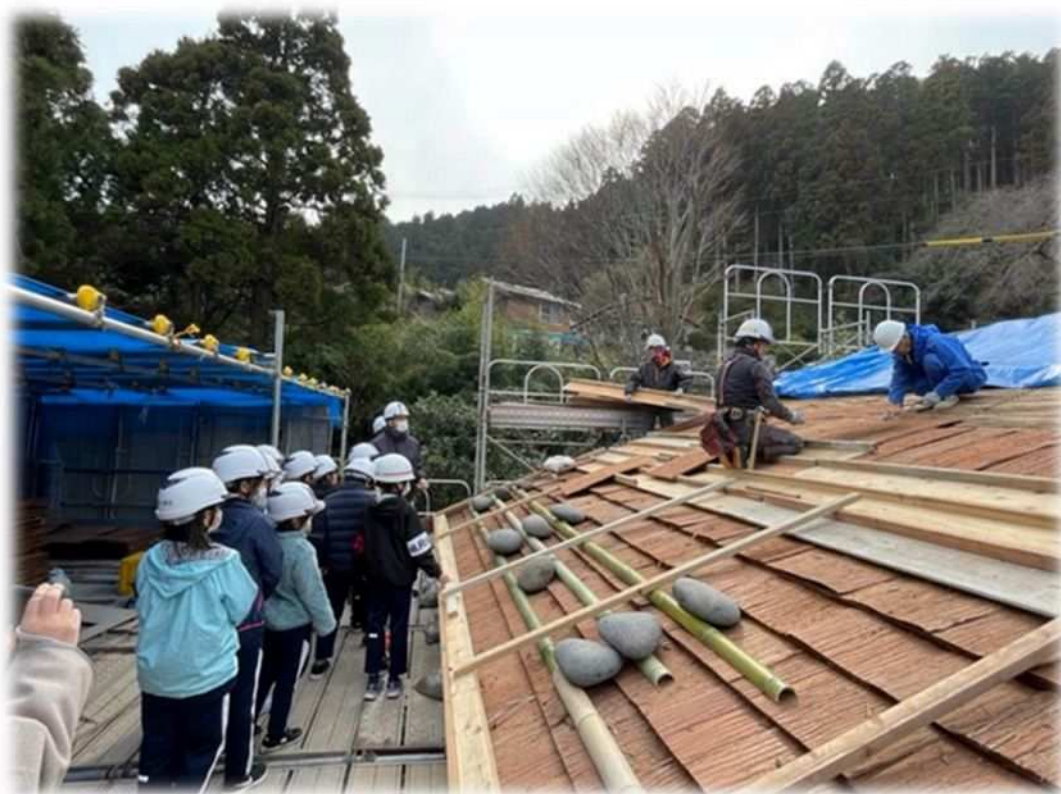
重要文化財佐々木家住宅保存修理工事見学の様子
