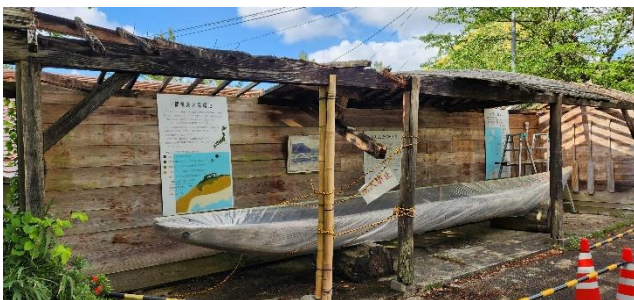
5月 からむし小屋 修理前
