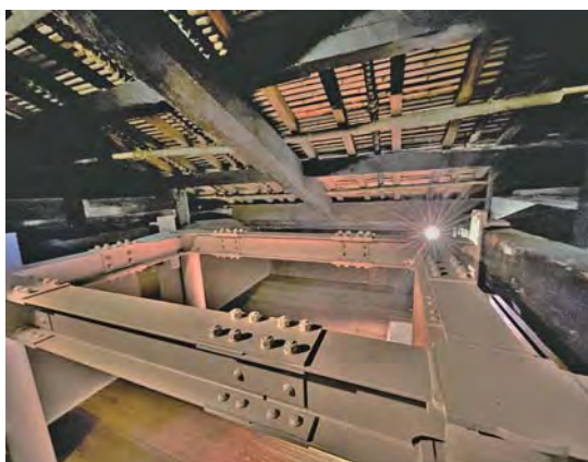
耐震補強のための鉄骨
