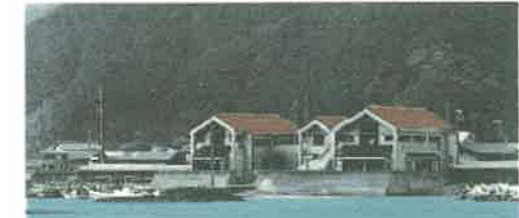
海に向かう切妻屋根(布施地区センター)
