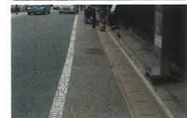
落ち着いた配色の歩車共存街路 (多治見市)
