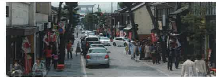
ユニバーサルな道路。松並木があり歩車道の段差がない (出雲市)
