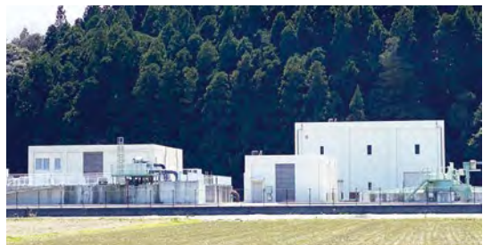
汚泥共同処理施設
