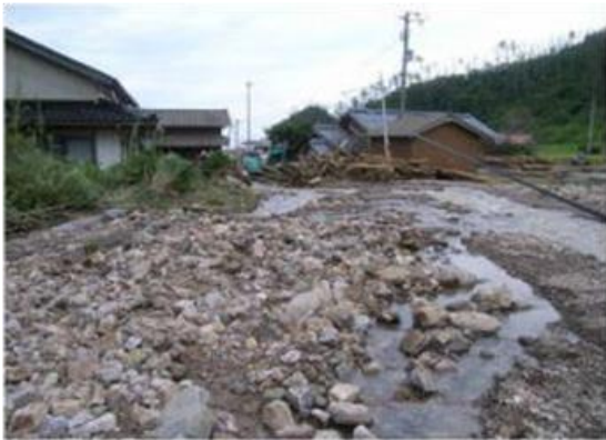
大津久川土石流被害状況
