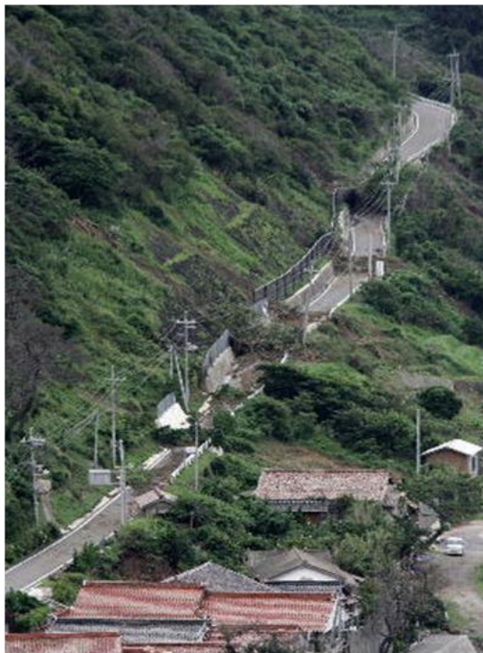
土砂崩れにより寸断された主要地方道西郷都万 郡線(油井地区)
