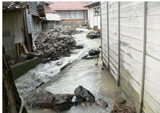
集落を走る水路への土石の流出(隠岐の島町那久地内)
