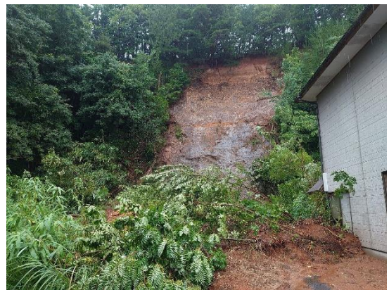
作業場 林地崩壊(有木地区)
