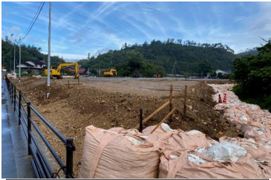
敷地造成工事の状況 (令和5年9月21日現在)
