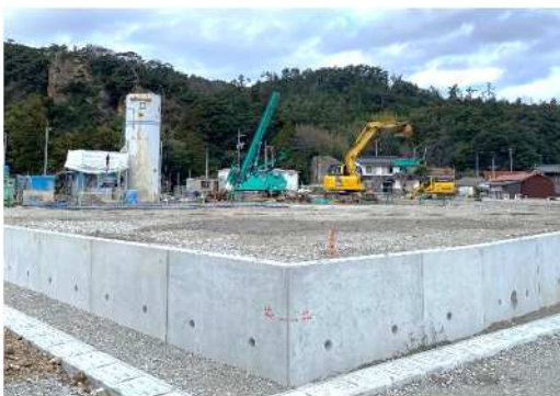
敷地の状況(令和6年2月16日現在)
