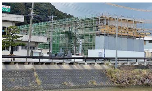
改修工事中の八田集合住宅
