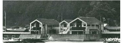
海に向かう切妻屋根(布施地区)
