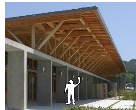
半屋外の底下は快適空間
