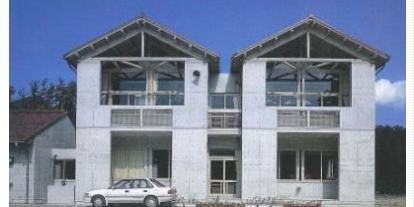
RC造+木造赤瓦屋根(五箇地区)
