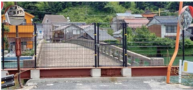
着工が遅れている愛の橋
