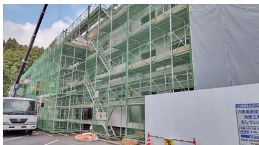
工事中の八田集合住宅
