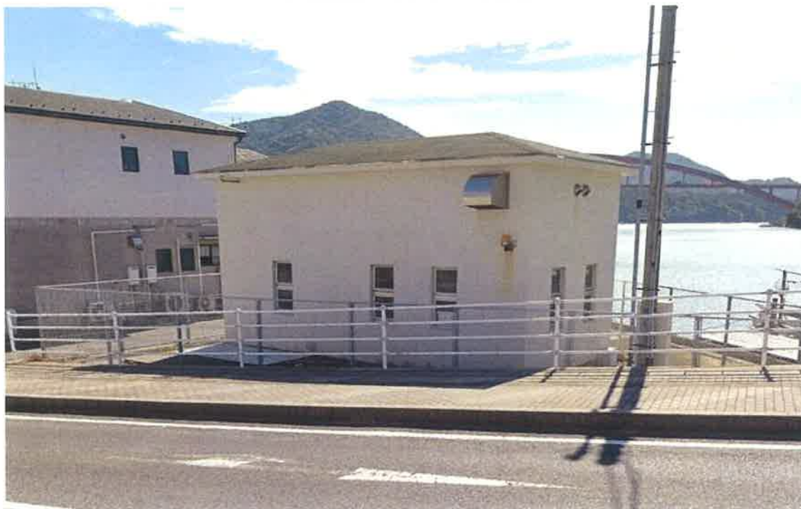
港町雨水第2ポンプ場（既設）
