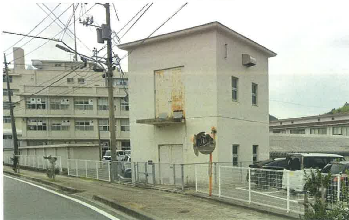
港町雨水第3ポンプ場（既設）
