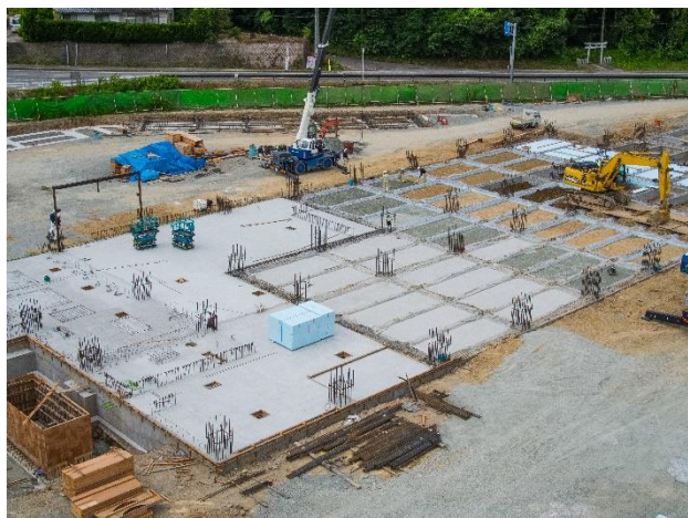
▲工事の状況（7月）
