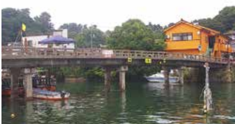
ボーリング調査中の愛の橋
