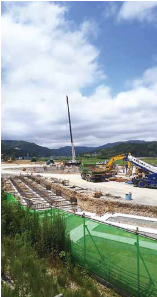
役場新庁舎建設現場
