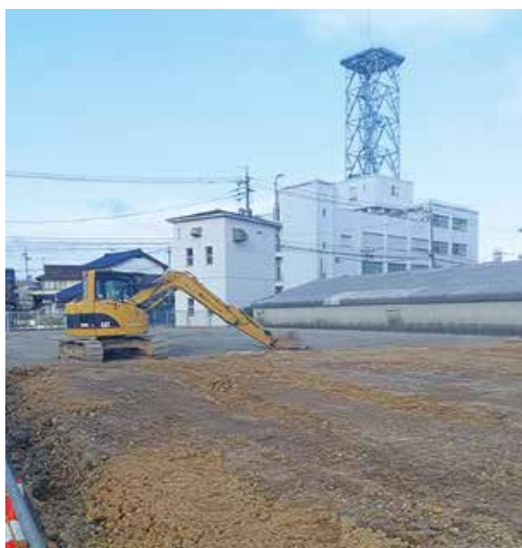
港町真空ポンプ場建設予定地
