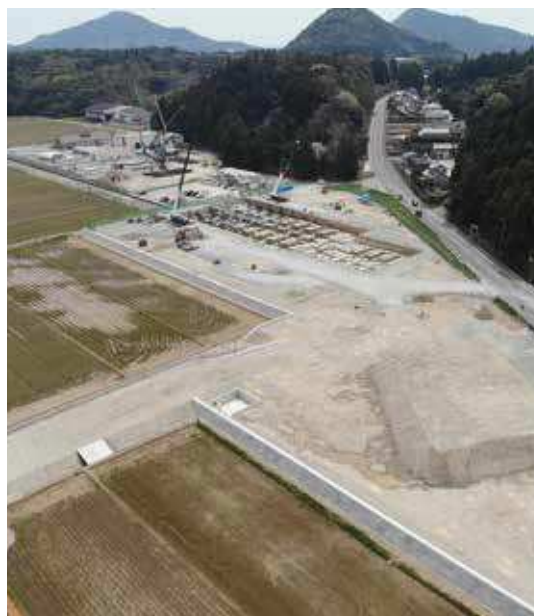
整備が進む新庁舎建設予定地
