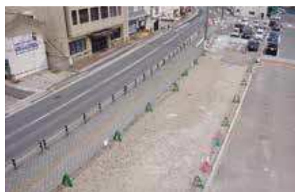
ジオパーク中核・拠点施設の建設用地
