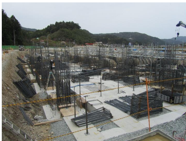
▲工事の状況（4月）
