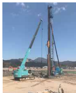
地中深く杭を打ち込む様子
