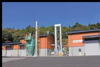
9月16日、再生可能エネルギーの普及を図るため、木質ペレットの生産などを行うバイオマス推進センターが竣工されました。
