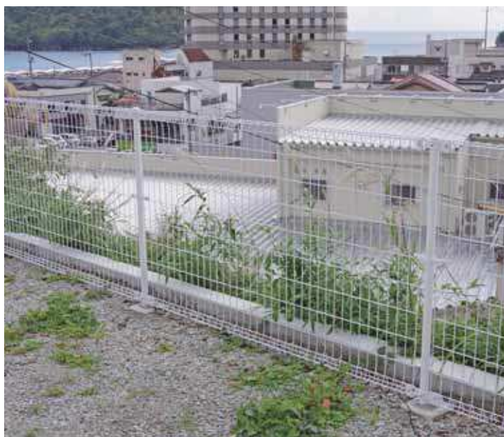
安全対策で設置されたフェンス
