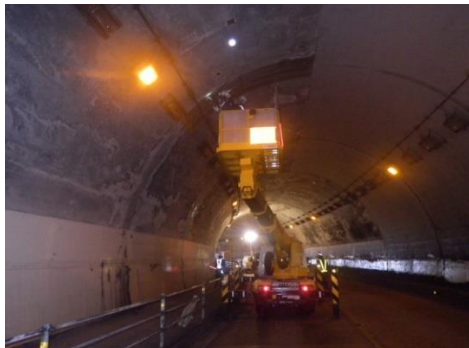
写真 3-1 FRP ネット設置状況
