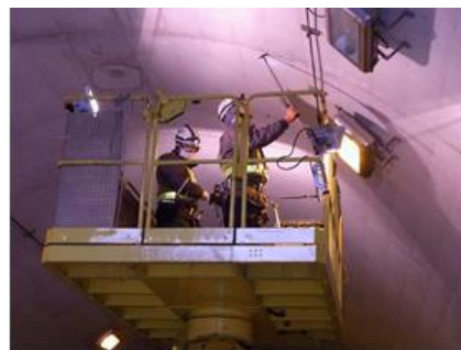
写真 2-1 トンネル点検状況
