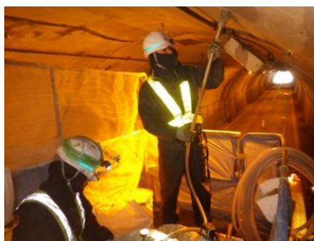
裏込注入状況
