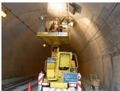
写真 2-1 トンネル点検状況
