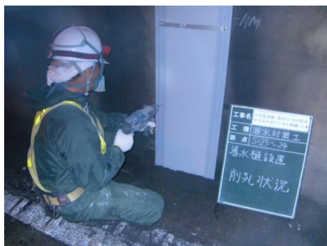
写真 3-2 線導水工
