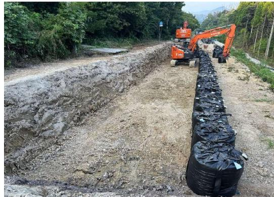
8月19日 被災区間の脆弱な土砂を撤去、土のう設置
