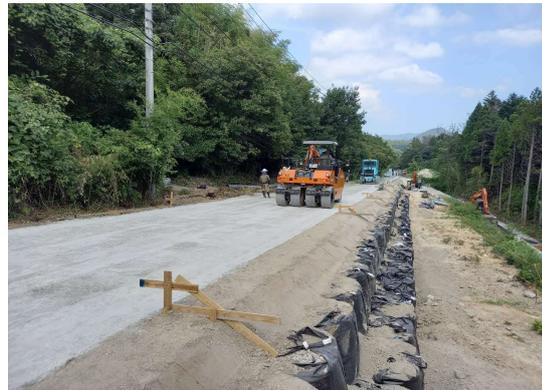
8月23日 舗装工（路盤）施工状況
