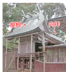
湊地区 湊神社（春日造） 屋根と向拝が一連につながっている。
