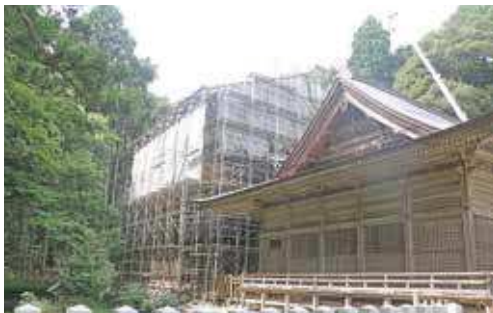
工事中の本殿の様子
