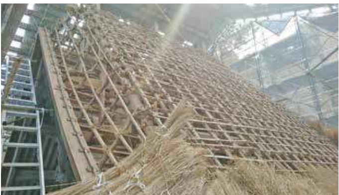
茅を撤去した屋根の様子
