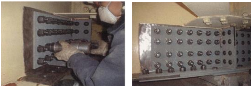
写真1： 当て板工実施状況
