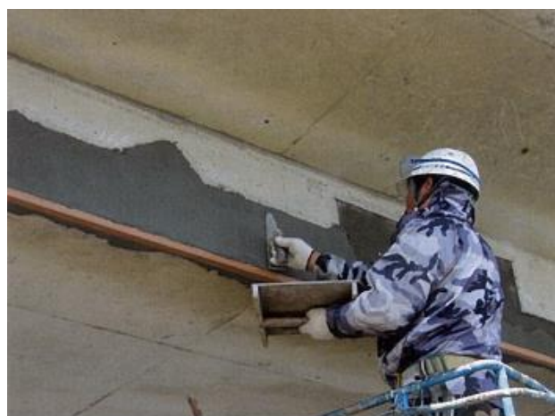
写真2： 断面修復状況
