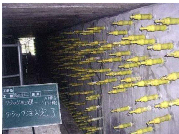
写真3： ひび割れ注入状況
