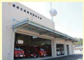
▲平地区に完成した隠岐広域連合消防本部の新庁舎
