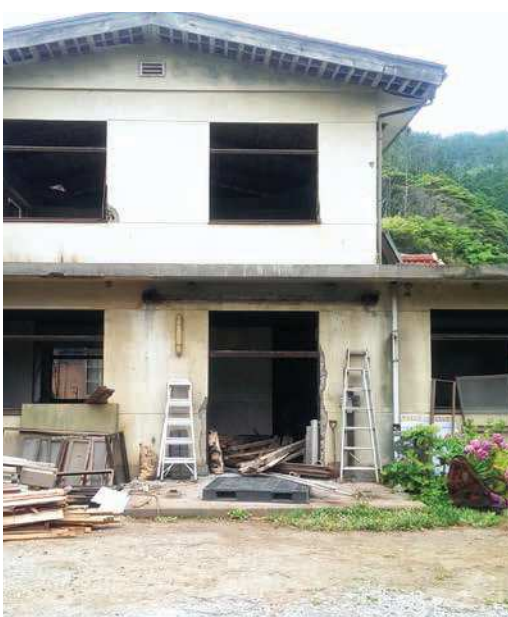
建設予定地の旧久見福祉館
