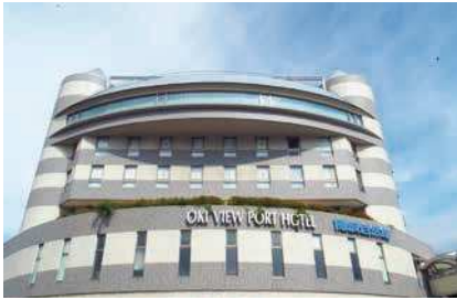
築20年経つポートプラザ
