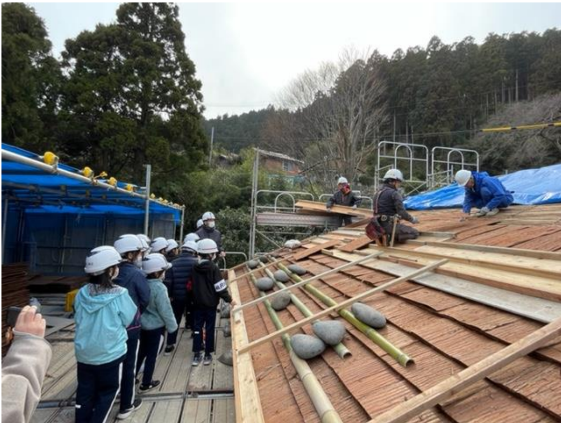
佐々木家住宅屋根葺替工事見学会（中条小学校）
