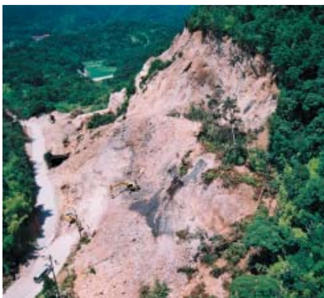
大規模な崩土が発生した西田箕浦線
