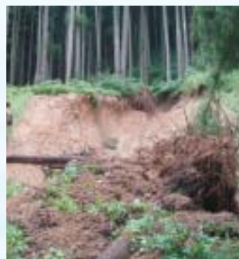
写真は林道歌木西線で発生した法面崩壊の様子
