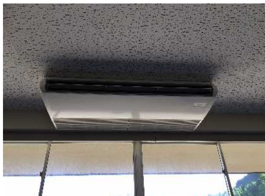
西郷南中学校空調設備（室内）
