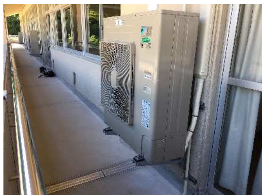
西郷南中学校空調設備（室外）
