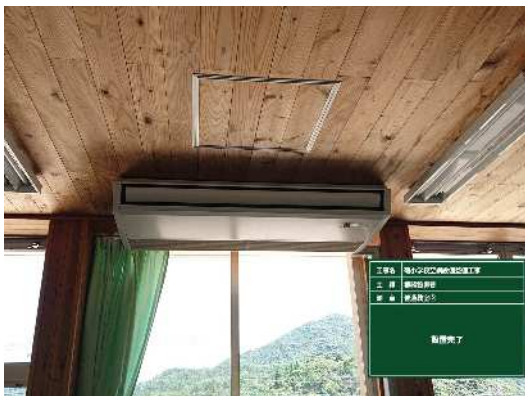
磯小学校空調設備（室内）
