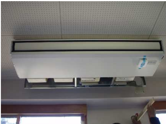
◇西郷小学校空調設備(室内)
