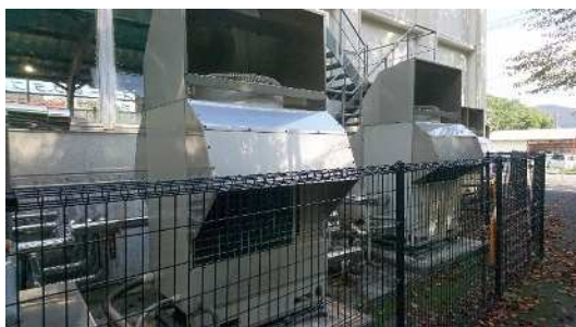
〔温水プールチラー修繕工事写真〕
