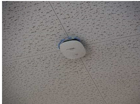
無線LANアクセスポイント (Wi-Fi電波を飛ばします)
