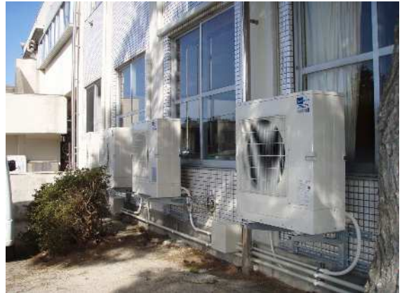
◇西郷小学校空調設備(室外)
