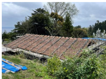
杉皮屋根葺き替え後
