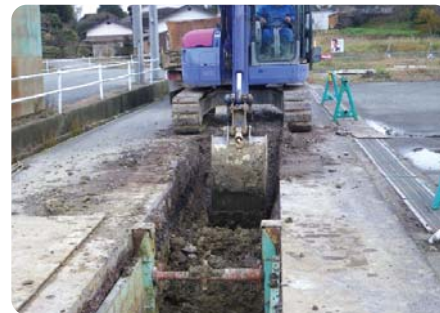
進む公共下水道工事
