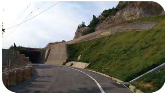
復旧が進む箕浦道路
