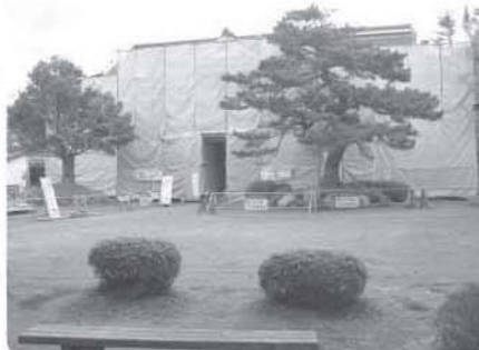
改修中の隠岐郷土館
