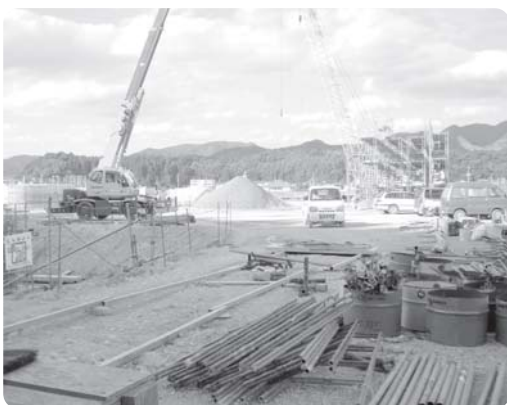
工事の進む終末処理場
