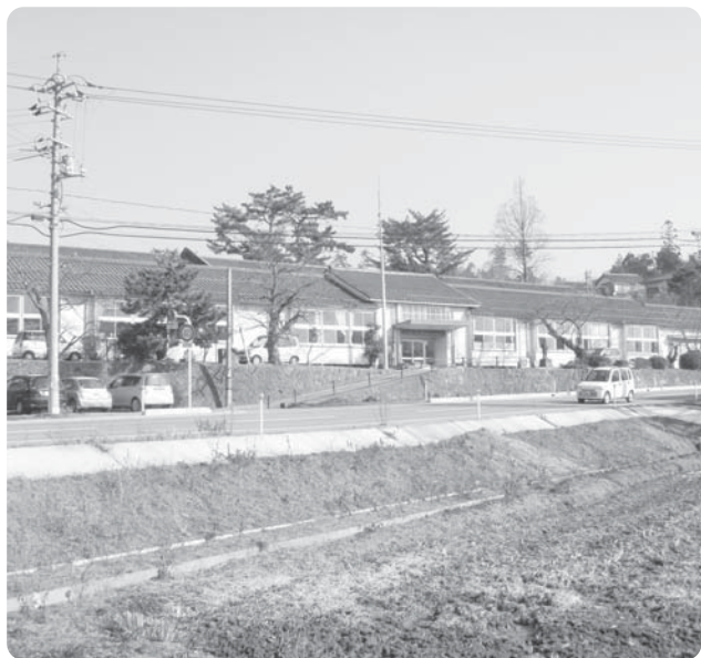
大規模改修予定の五箇小学校
