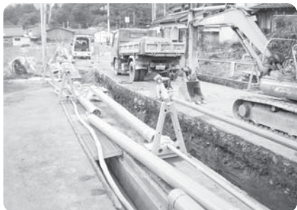
進む下水道工事
