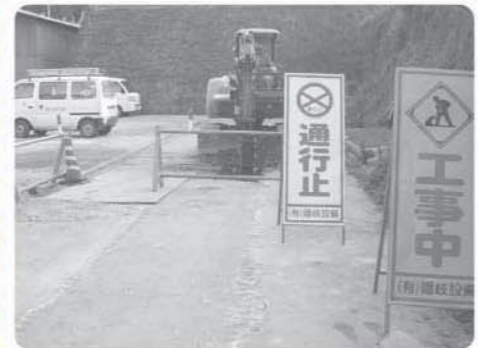
下水道工事現場
