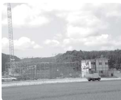
工事中の浄化センター
