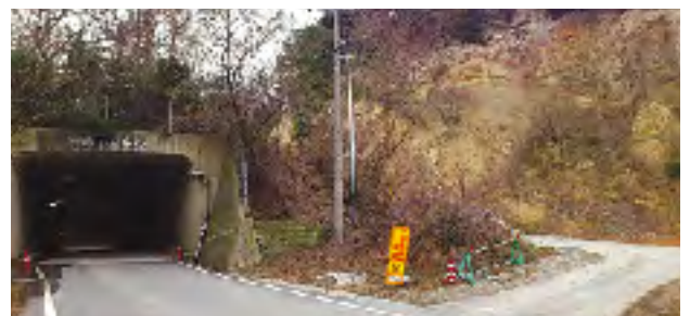
完成間近の箕浦トンネル
