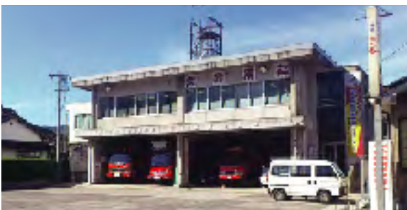
新築、移転を待つ本部庁舎
