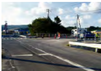
隠岐病院入口
